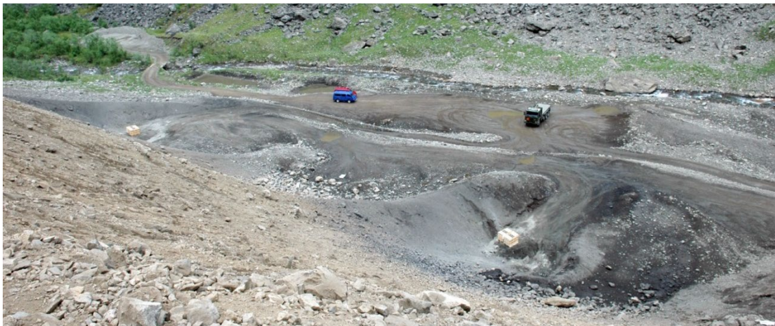
Figur 1.2 Demoleringsgropene på destruksjonsanlegget i Øyradalen slik de så ut i 2006.
