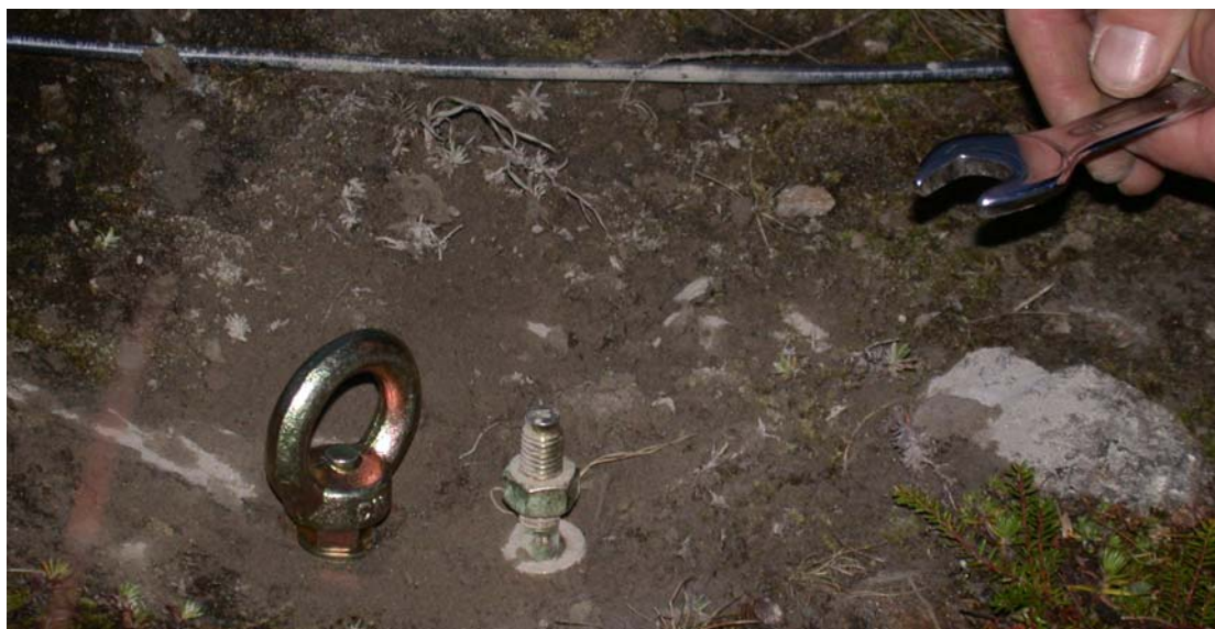
Figur 5.2 Ekspansjonsbolt med øye boret og slått ned i bakken.
