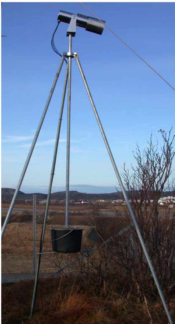
Figur 5.5 Tripodmast ferdig montert med 40 kg ballast.
