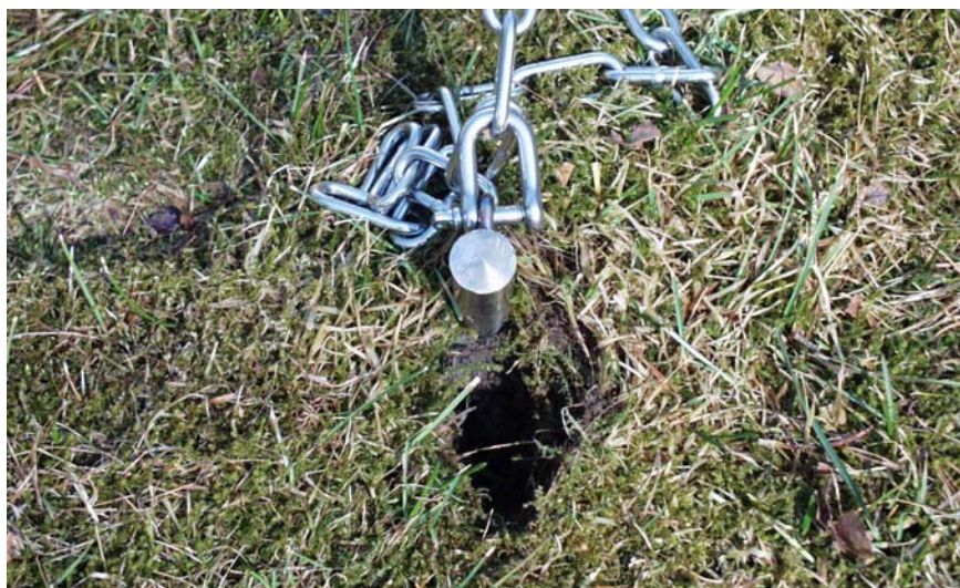
Figur 2.5 Første forsøk på bardunfester ble for dårlig. Grunnen har gitt seg ved stramming av bardunene
