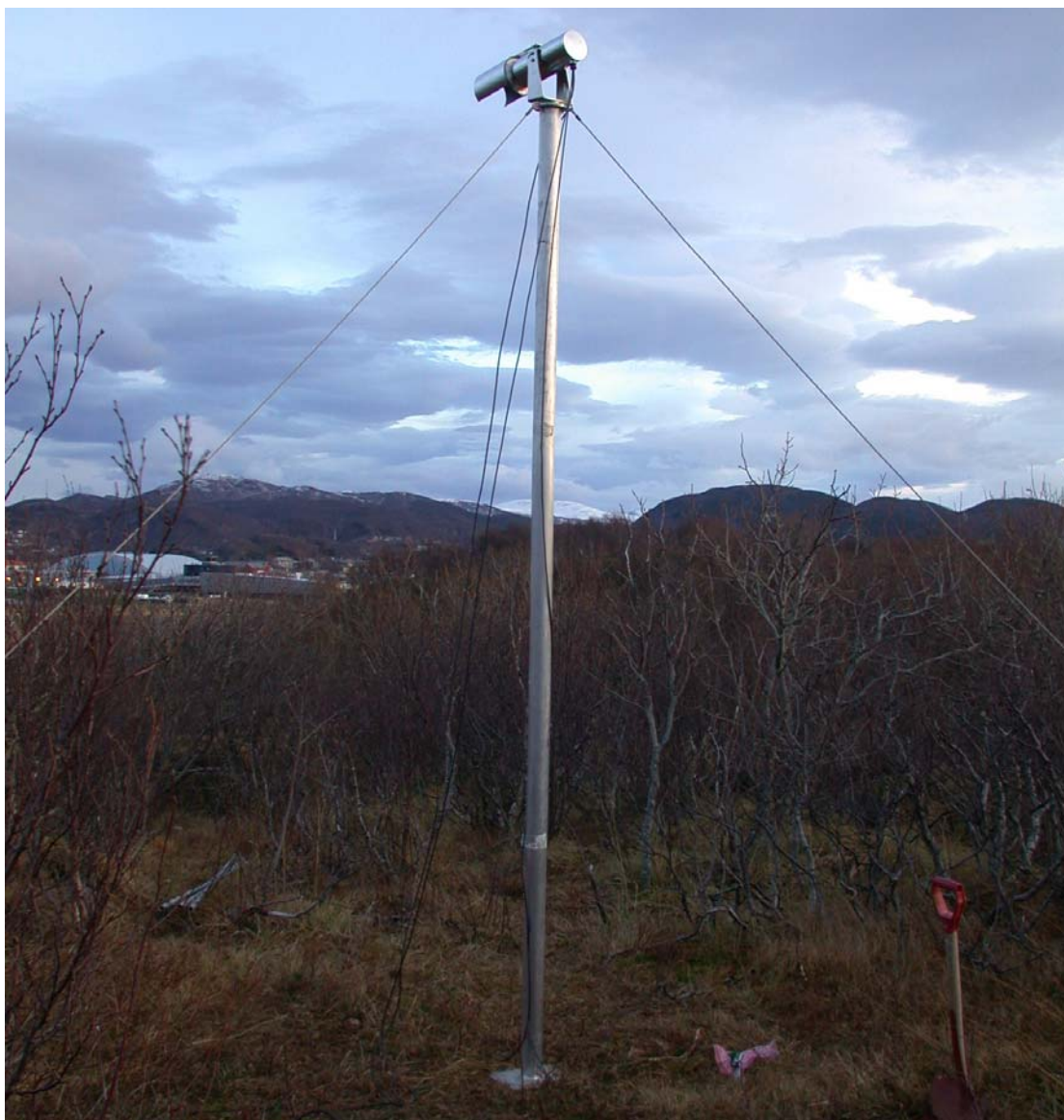
Figur 5.3 Bardunert mast ferdig montert på Bodø flystasjon.
