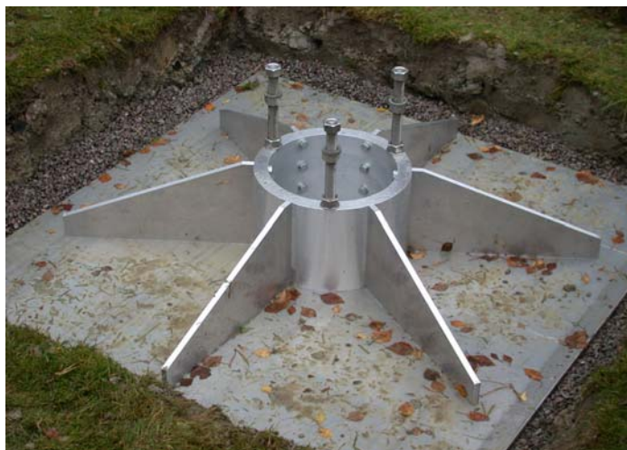
Figur 2.2 Bunnplate for feste av fagverksmast.
