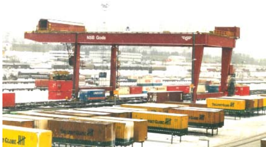
Figur 2.3 Lo-Lo kran på jernbanens hovedgodsterminal på Alnabru
