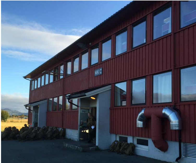
Figur 2.4 MK C, Luftvern bataljonens kaserne på Ørland flystasjon.
